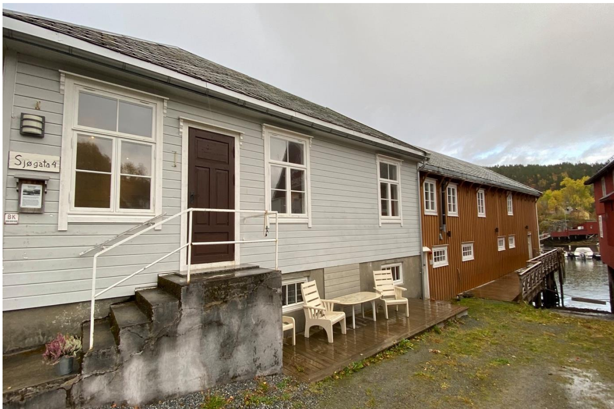
Figur 7 Sjøgata Arbeidslag – fasade
